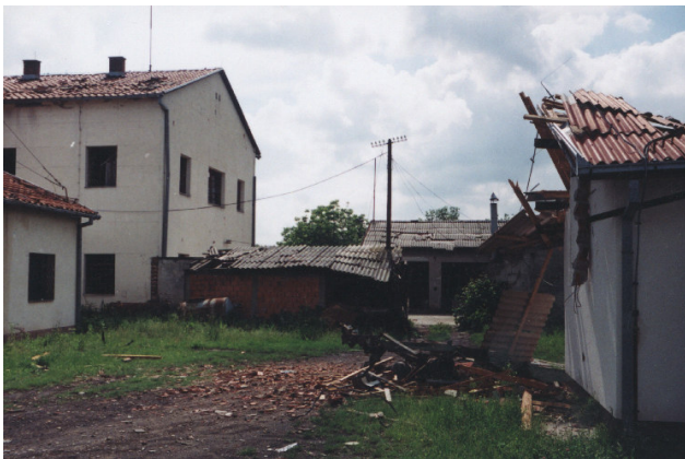
Zgrada Istorijskog arhiva Šumadije u Kragujevcu posle bombardovanja 1999. godine
