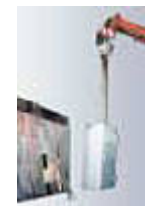
Postavitev in montaža trezorskih vrat
