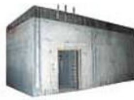
Trezorski prostor po zalitju z betonsko mešanico in razopaženjem
