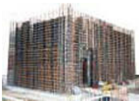
Varnostna in statična armatura trezorskega prostora, pripravljena za opaženje in nato zalitje z betonsko mešanico
