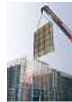
Postavitev in montaža stenskih varnostnih armatur
