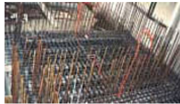
Postavitev varnostne in statične armature se opravlja sočasno
